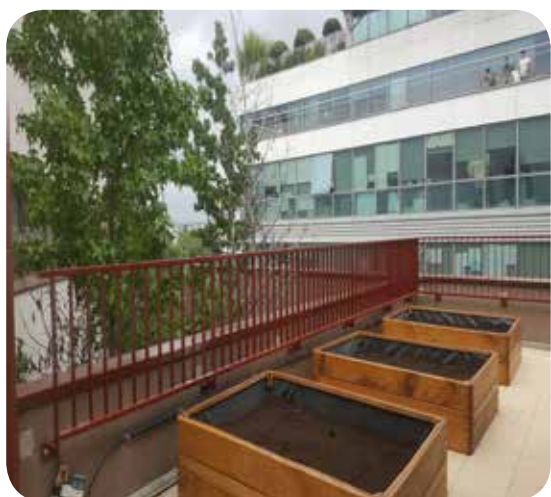
Crédits photo : © Paul ROBINOT, prises le 30/08/2017 Installation de bacs de culture à but pédagogique sur les toitures terrasses du collège George Mandel à Issy-les-Moulineaux
